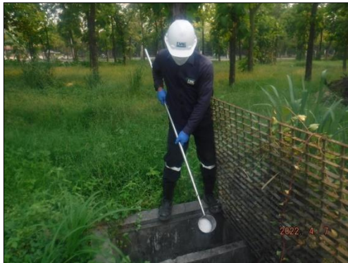
รูปที่ 2-13 บ่อแยกน้ำมัน เพื่อแยกน้ำมันออกจากน้ำฝน ที่ตกในพื้นที่โครงการฯ
