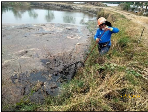
รูปที่ 2-21 ตรวจสอบการอุดตันของทางน้ำ ในบ่อบำบัดต่างๆ
