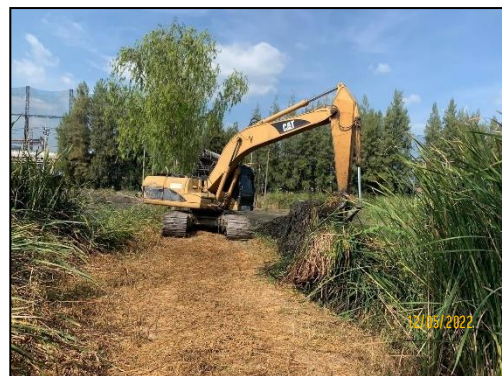
รูปที่ 2-24 การขุดลอกบ่อเก็บน้ำดิบก่อนเข้าช่วงฤดูฝน
