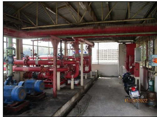
รูปที่ 2-62 บั๊มน้ำดับเพลิง
