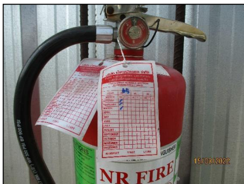
รูปที่ 2-59 ถังดับเพลิงภายในโครงการฯมีการตรวจสอบสภาพ เป็นประจำทุกเดือน
